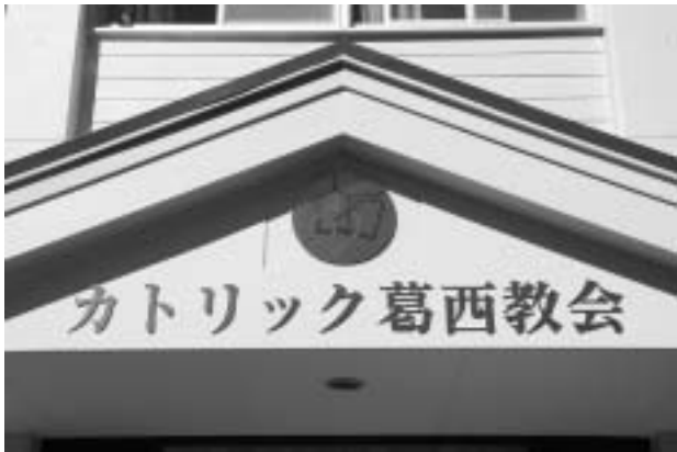
補修工事も無事に終了し、 聖アウグスチノ修道会のシンボルマークも 新しく取り付けられました
